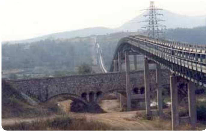
Curvodic™ de 16 km en Chine Liaison carrière-cimenterie en calcaire à 2 000 t/h 8 rayons d'environ 2 500 m
