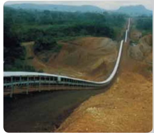
Curvodic™ de 6 km au Gabon. Liaison carrière-usine d'expédition en minerai de manganèse à 800 t/h
